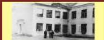
Здание школы после отступления немецко-фашистских захватчиков 1942 год
